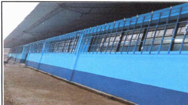
Foto 2: COLOCACION DE VENTANAS Y BALCONES EN LAS AULAS DE QUINTO Y SEXTO PRIMARIA
