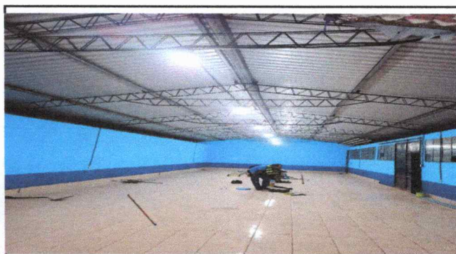
Foto 4: REPARACION DEL SISTEMA ENECTRICO EN EL MODULO DE PREPRIMARIA
